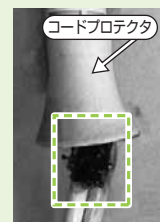
写真3 電源コードの損傷
